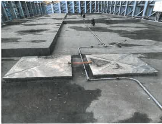
รูปที่ 16 ฝาดักเก็บน้ำสำรอง บริเวณฝาดักเก็บน้ำชั้นหลังคา
