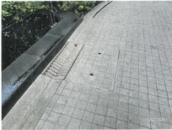
รูปที่ 69 ตะแกรงครอบตามรูท่อระบายน้ำทั้งภายในและภายนอกอาคาร
