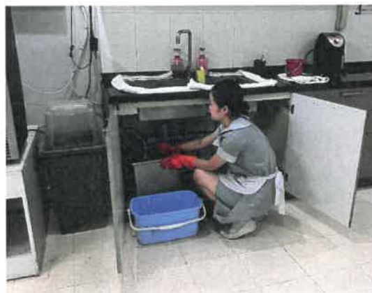
รูปที่ 93 พนักงานดักไขมันจากถังดักไขมัน
