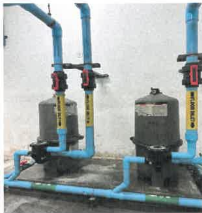
รูปที่ 83 ระบบกรองน้ำสระว่ายน้ำ
