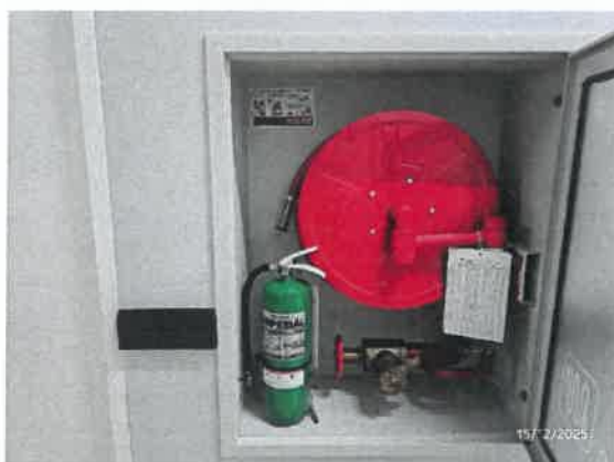
รูปที่ 54 ตู้เก็บสายฉีดน้ำดับเพลิงพร้อมอุปกรณ์ (Fire Hose Cabinet : FHC) ไว้ภายในอาคาร
