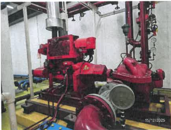
รูปที่ 49 เครื่องสูบน้ำดับเพลิงอยู่ในห้อง เครื่องสูบน้ำดับเพลิงภายในอาคารบริเวณชั้นที่ 1
