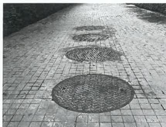
รูปที่ 14 บ่อตรวจสอบคุณภาพน้ำในถังน้ำใส
