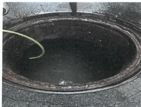
รูปที่ 12 การสูบล้างปลักและตะกอน
