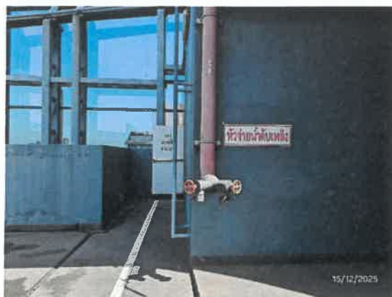
รูปที่ 53 ตู้รับน้ำดับเพลิงภายนอกอาคาร (FDC)
