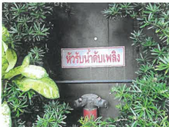
รูปที่ 53 ตู้รับน้ำดับเพลิงภายนอกอาคาร (FDC)
